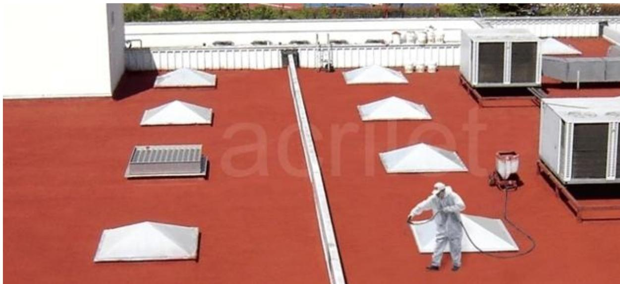
**Мастика ACRILET 198** - это высококачественный полимерный состав для устройства цветного покрытия для плоской и скатной кровли (цветная жидкая резина). Получаемое покрытие является очень прочным (подобно "линолеуму"), эксплуатируемое, устойчивое к УФ излучению, низким и высоким температурам.
